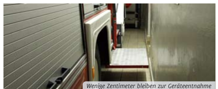
Engste Platzverhältnisse im ganzen Gebäude
