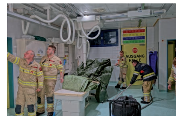
^ Wasserschaden , Notaufnahme KH Schwaz
